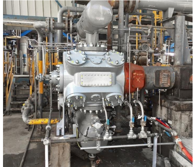
Installation der neuen Zylinder im Zuge der Modernisierung. Die Zylinder von Burckhardt Compression entsprechen den Anforderungen der 5. Auflage der Design-Richtlinie API 618.
